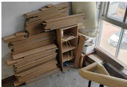
1、翠湖小区 160 号楼 2 单元楼道问题
