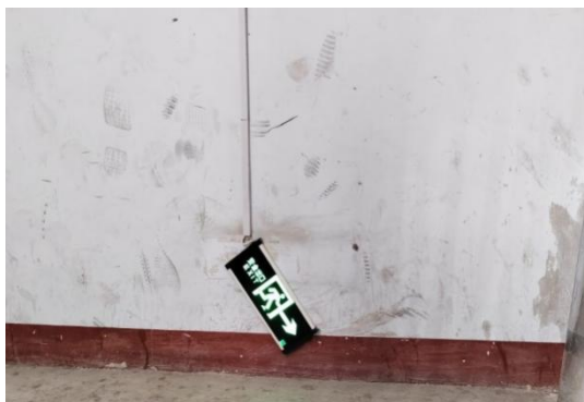
2、翠湖小区 160 号楼 2 单元楼道问题
