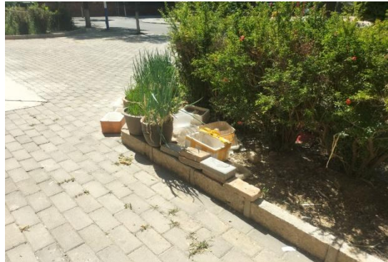
2、科苑小区 1 号楼室外问题
