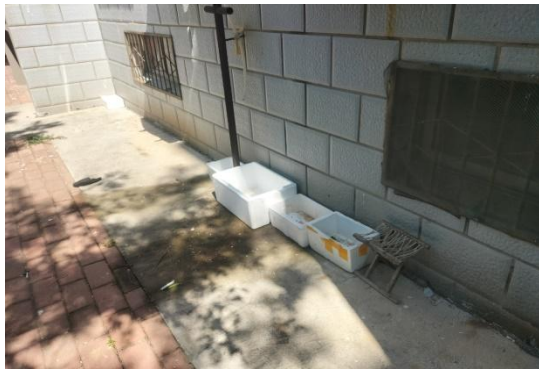
15、科苑小区 14 号楼室外问题
