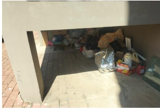
14 科苑小区 14 号楼室外问题
